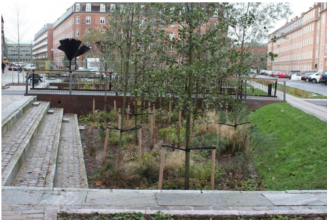
Imagen 20. 16. Estanque de laminación con un talud escalonado de adoquines y otro de suelo vegetado. Fuente: Elaboración propia
