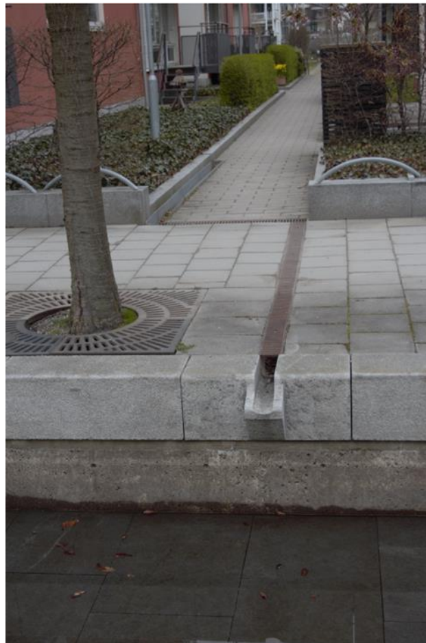
Imagen 20. 15. Una de las múltiples entradas laterales de estanque de laminación de tipo infraestructura gris. Fuente: Elaboración propia
