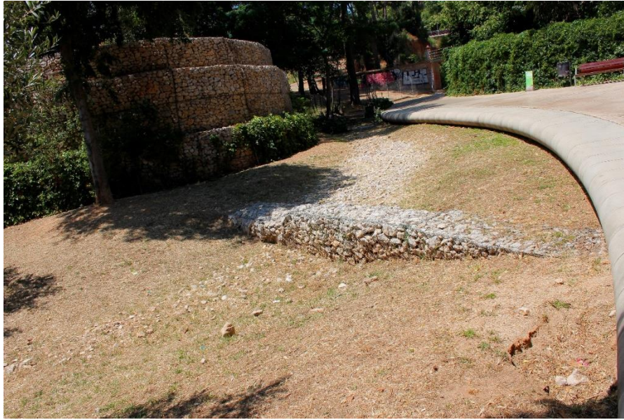
Imagen 16. 7. Represa en cuneta verde. Fuente: Elaboración propia
