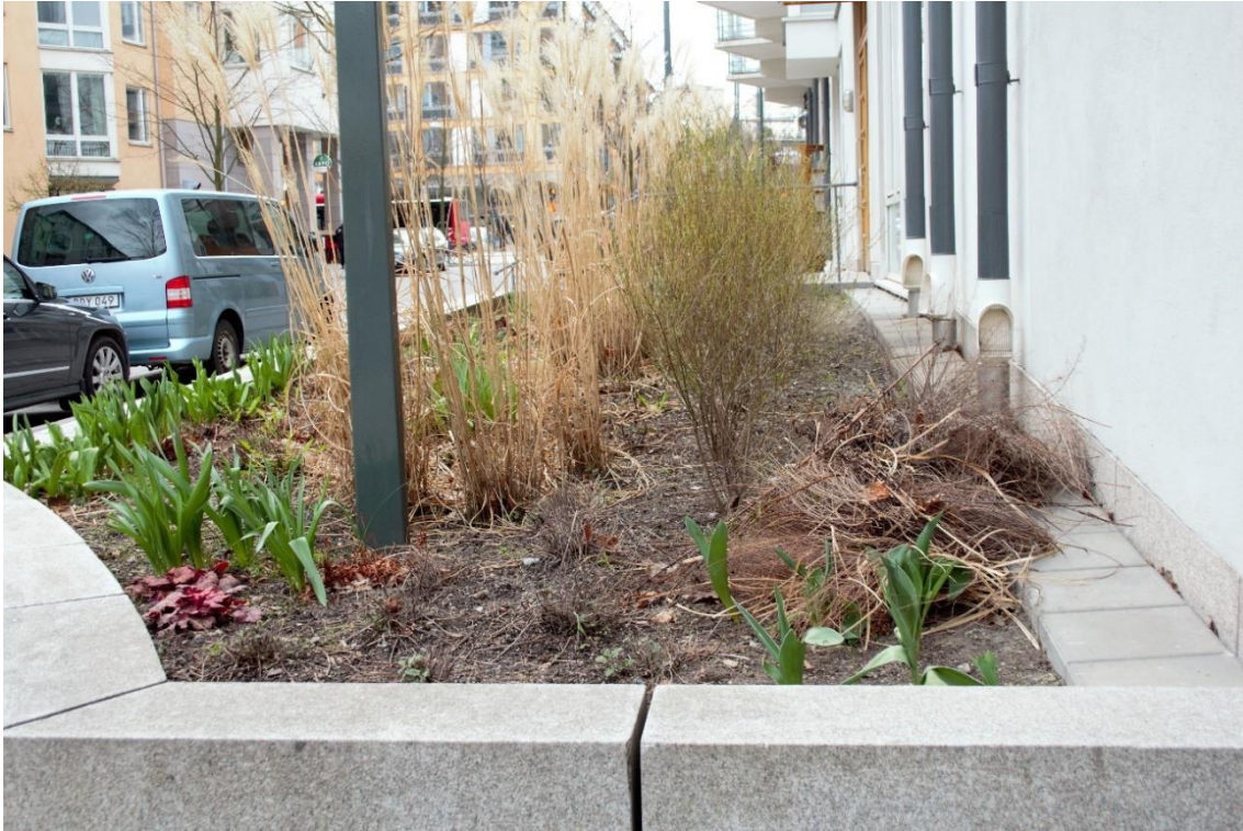
Imagen 17. 12. Ejemplo de entrada desde bajante, la salida del agua desde el tubo se realiza sobre unas losetas que sirven para evitar la aparición de socavones en el suelo puesto que desde ahí el agua cae de forma laminar. Fuente: Elaboración propia
