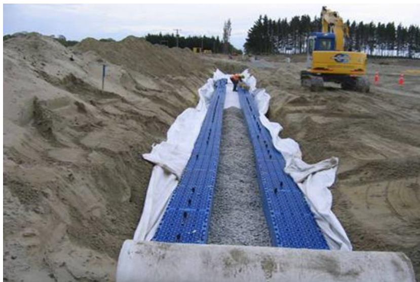
Imagen 13. 5. Construcción de una zanja de infiltración con celdas plásticas. Fuente: Amanco
