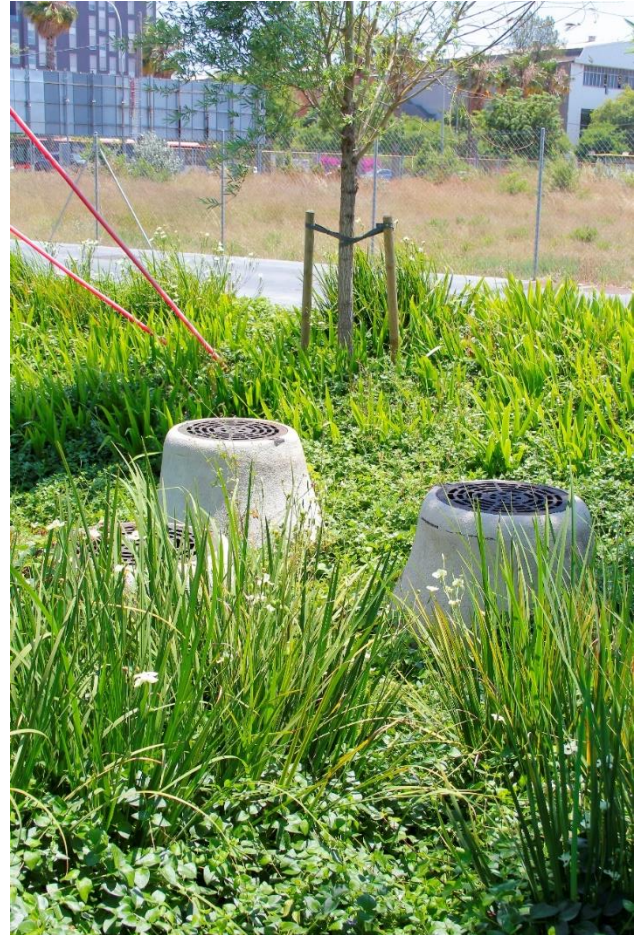
Imagen 17. 9. Salida por cámara de desbordamiento. Fuente: Elaboración propia
