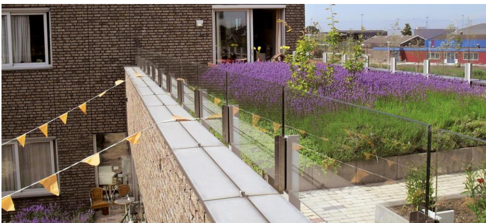
Imagen 11. 3. Techo semi-intensivo. Fuente: Zinco
