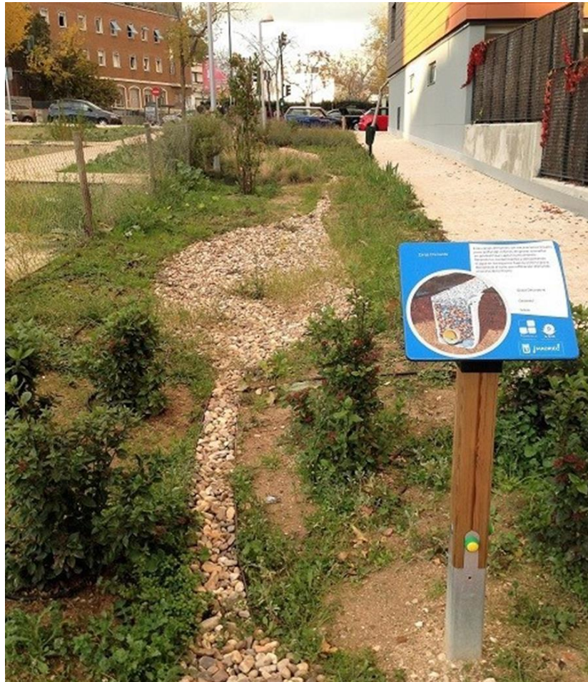
Imagen 17. 10. Ejemplo de zona de biorretención de forma irregular. Fuente: Elaboración propia
