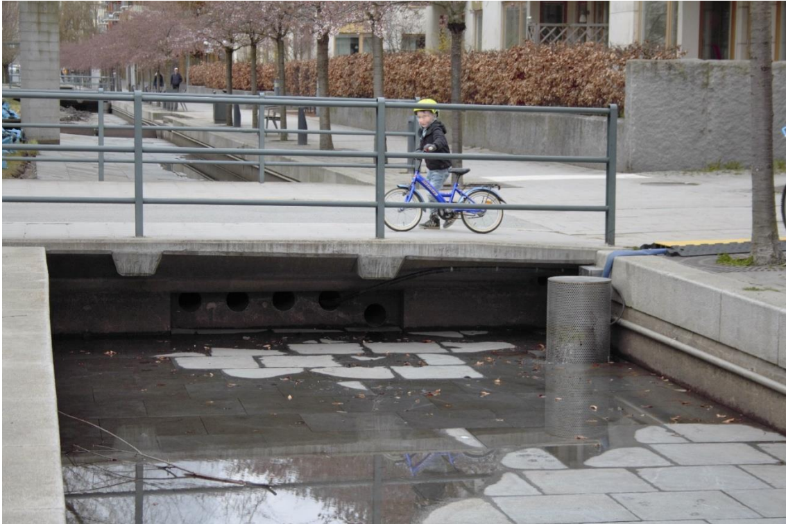
Imagen 20. 14. Infraestructura gris de acumulación y laminación con salida al siguiente depósito superficial. Fuente: Elaboración propia
