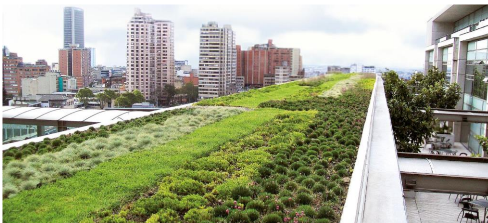
Imagen 11. 1. Techo verde extensivo. Fuente: Zinco
